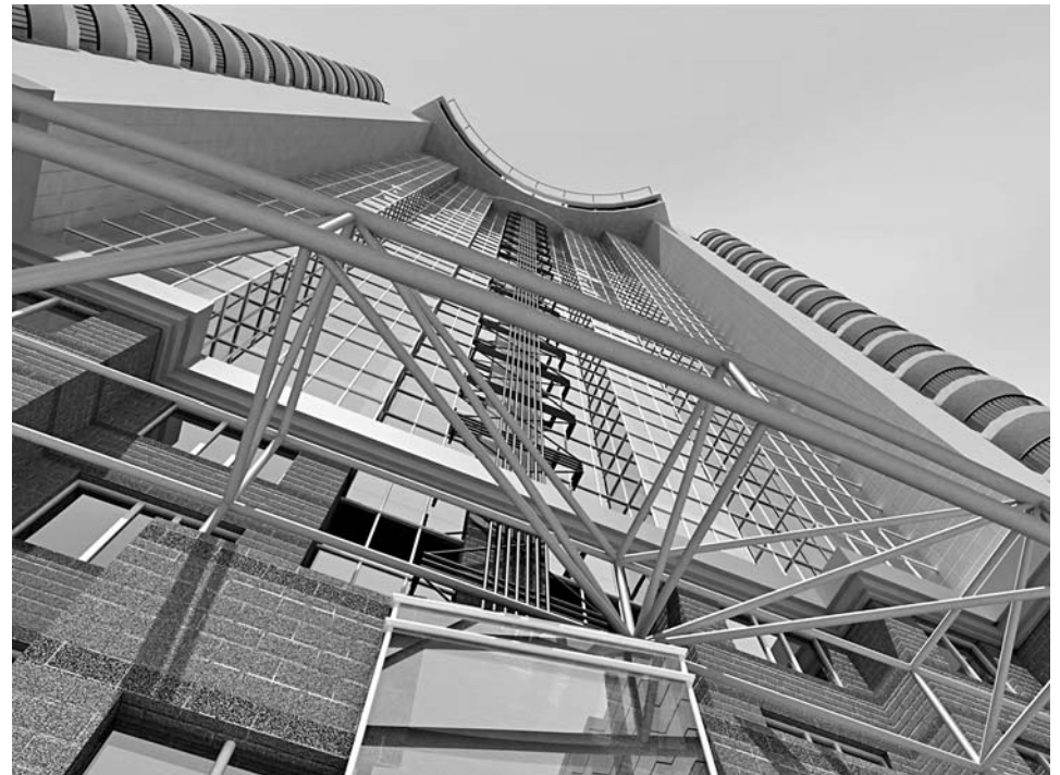
Жилой дом с подземной автостоянкой. Фили-Давыдовское, кв. 1-2 кор. 2АБВ (1-я очередь). Фрагмент фасада.
